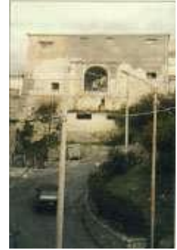
La porta oggi: demolita la scala per realizzare la variante della strada
